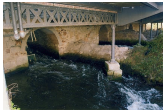
CANALES DE LA HARINERA EL SUR, ACTUAL HOTEL CASINO ▼
