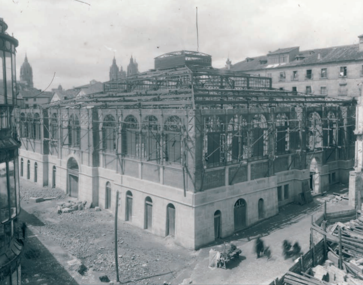
EL MERCADO DE ABASTOS EN CONSTRUCCIÓN. 1906 (FOTO VENANCIO GOMBAU) ▲
